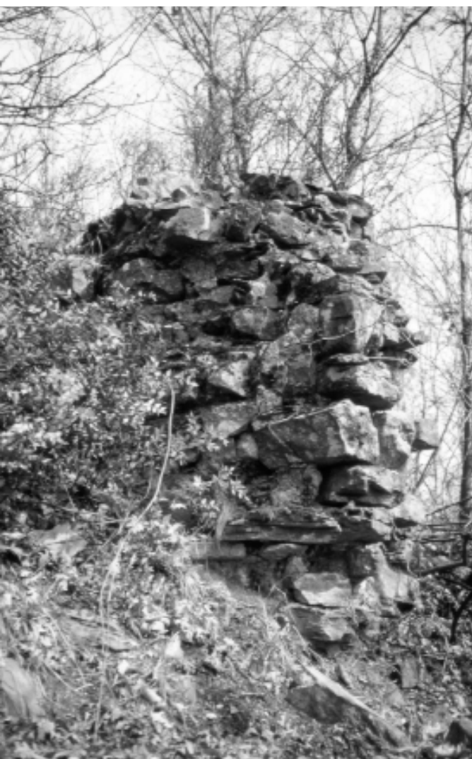
Castello di Castiglioni: struttura muraria medioevale
