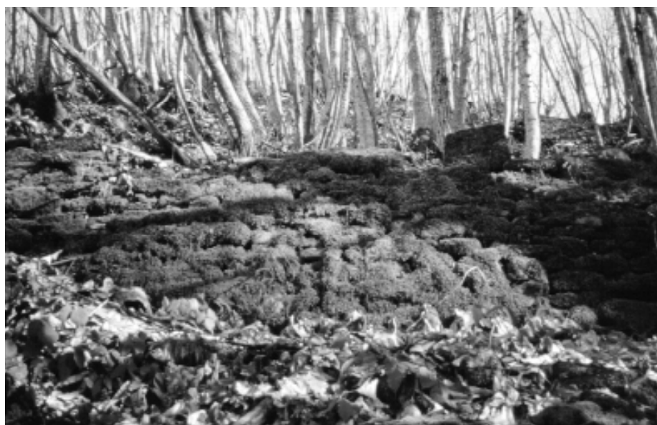
Castellaccio di Castiglione: particolare della struttura muraria sul versante occidentale
