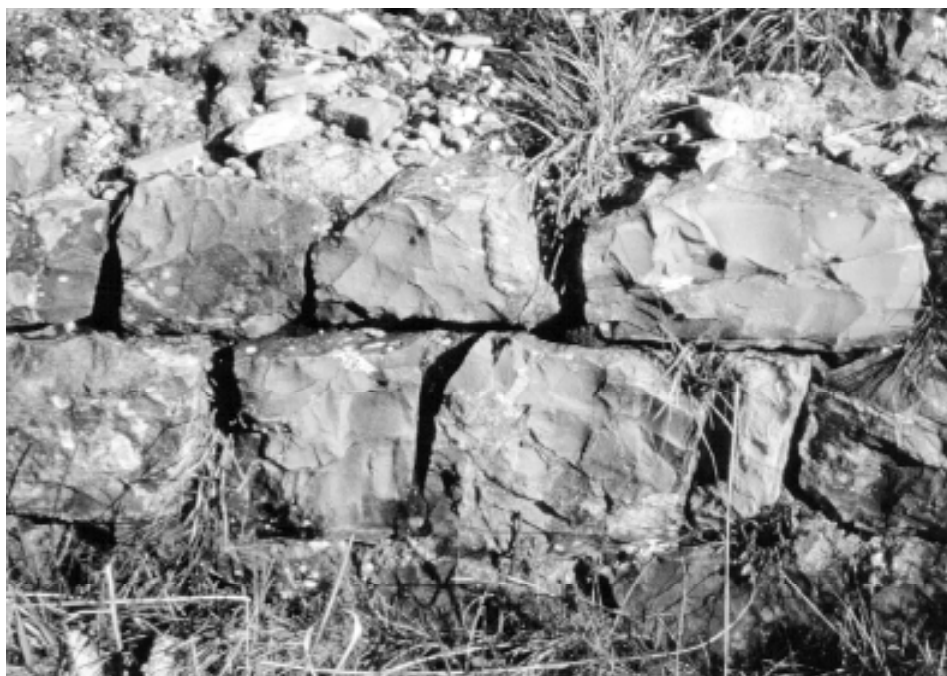
Castello di Mogone: particolare delle mura realizzate in calcare alberese
