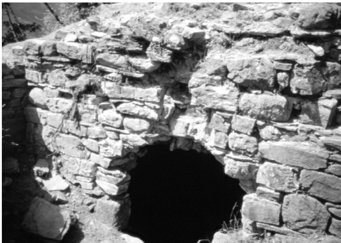
Rocca di Cerbaia: un probabile deposito di munitiones nella parte esterna della rocca.
