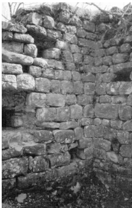
Castello di Civitella: particolare dell'angolo interno verso Poggio Castello di Baragazza (con gli innesti delle palificazioni del camminamento di ronda)
