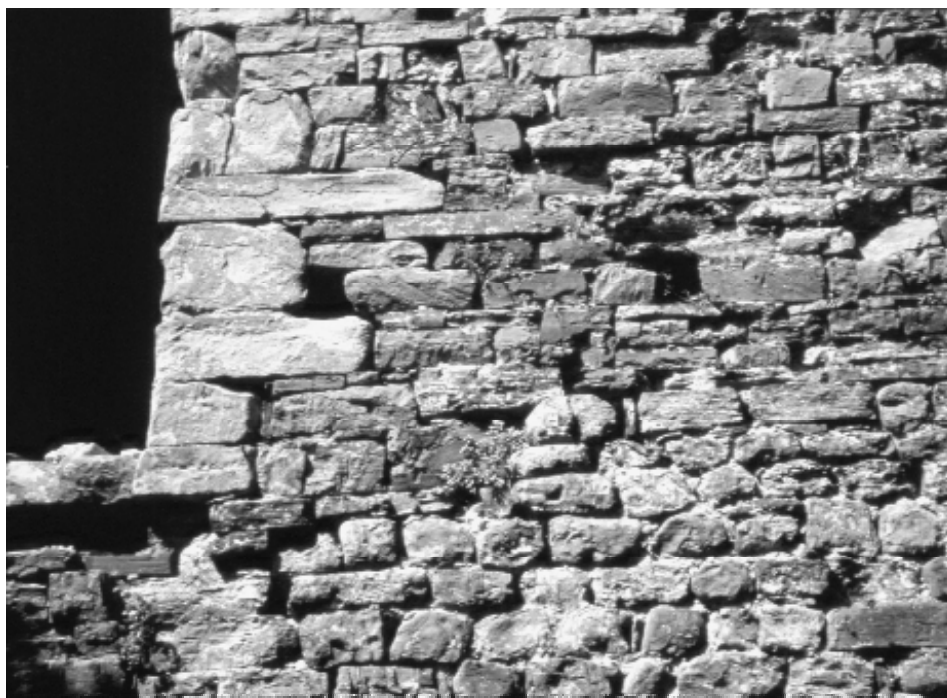
Rocca di Cerbaia: particolare della struttura interna delle mura.
