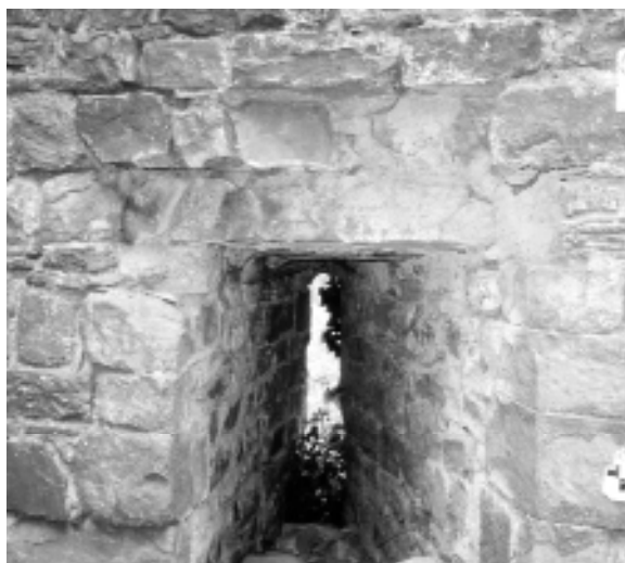
Rocca di Cerbaia: una delle due feritoie probabilmente funzionali al passaggio di cavi o di catene levatoie.
