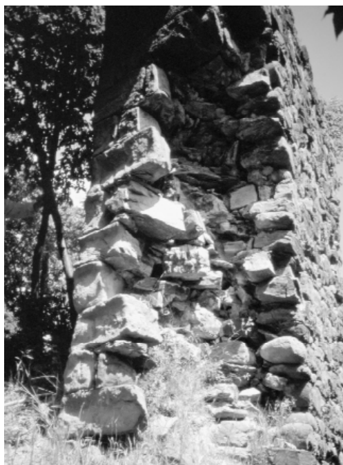
Rocca di Cerbaia: evidenti erosioni ai piedidel- le mura del mastio
