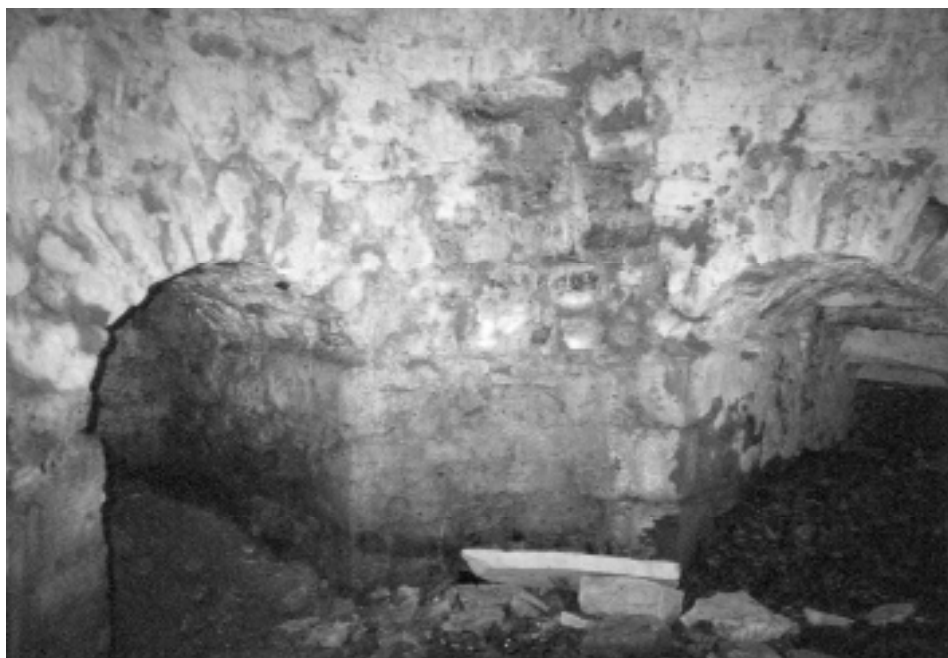
Interno della cannoniera (casamatta o camera di volata) con gli alloggiamenti per cannoni (XVI sec.)
