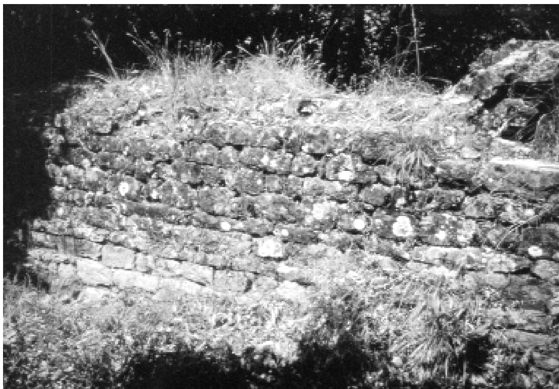
Torre di Cavarzano: particolare della struttura muraria della Torre
