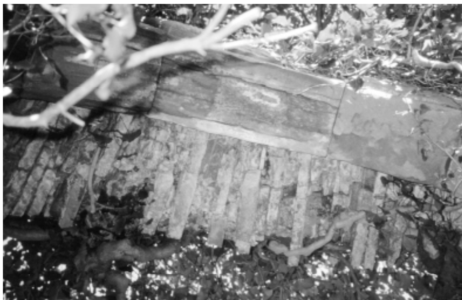
Rocca di Vernio: particolare della struttura, in mattoni e conci di arenaria, della volta di un arco nelle mura del mastio
