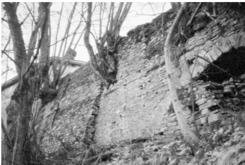
Castello delle Mogne: struttura muraria lato Nord
