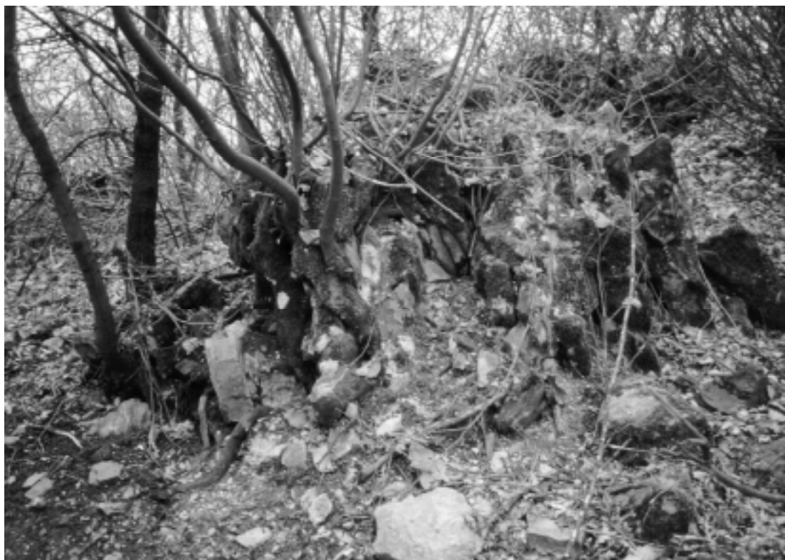
Castello di Castiglioni: strutture murarie medioevali parzialmente coperte da vegetazione
