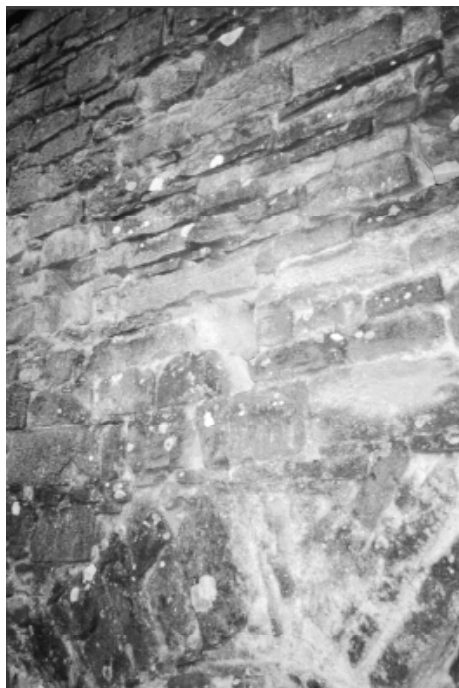
Castello delle Mogne: particolare della struttura muraria della parete Nord
