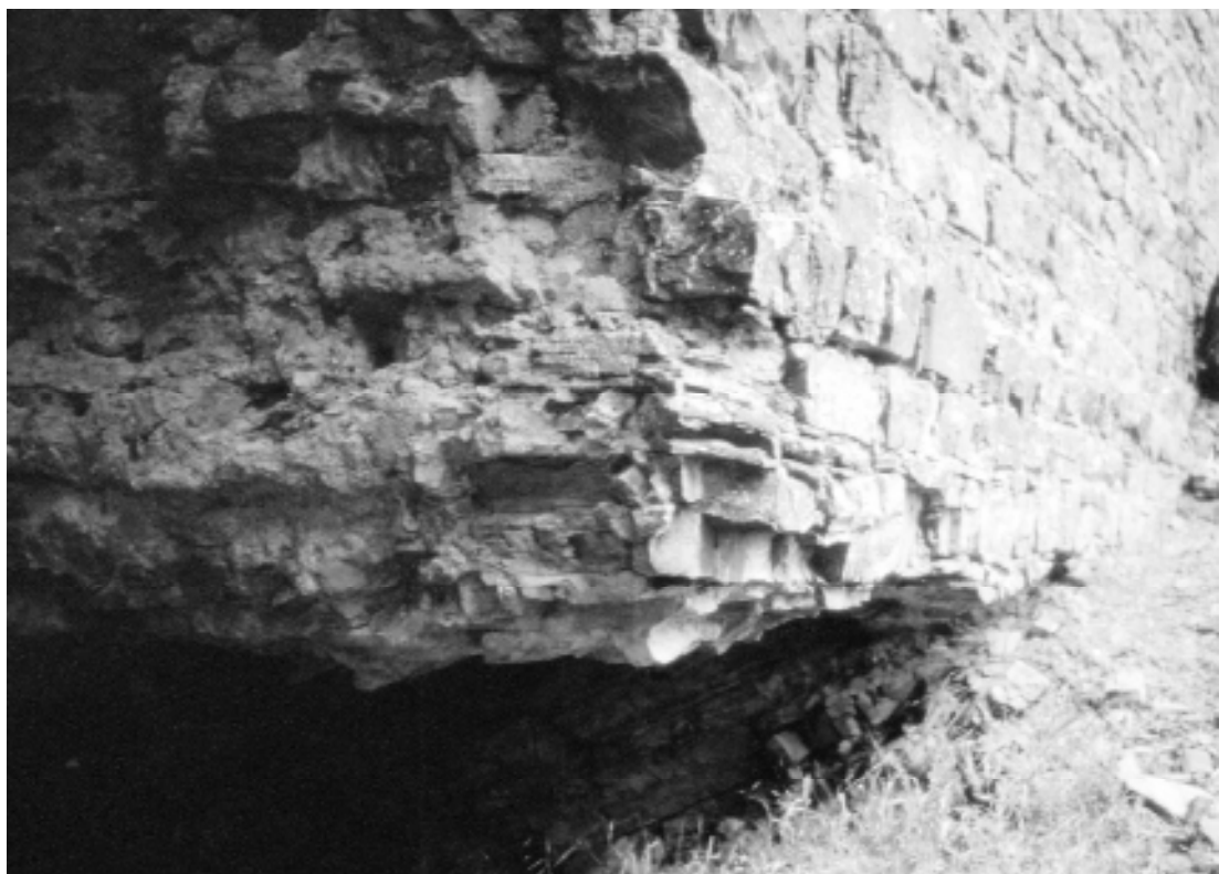
Rocca di Cerbaia: evidenti erosioni ai piedidel- le mura del mastio
