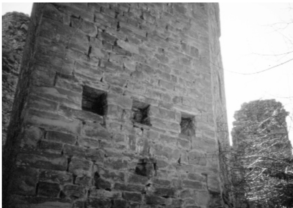
Rocca di Cerbaia: il torrione centrale del mastio con gli incassi per la palificazione del ballatoio
