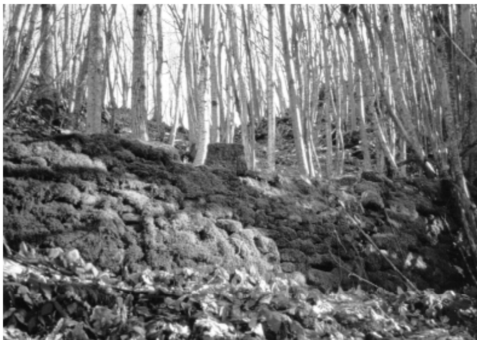
(a) FIGNAGNANI pag. 70 Castellaccio di Castiglione: strutture murarie medioevali sul lato occidentale
