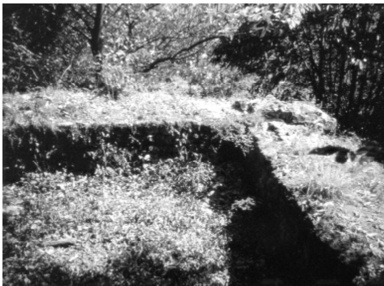
Torre di Cavarzano: la struttura della Torre
