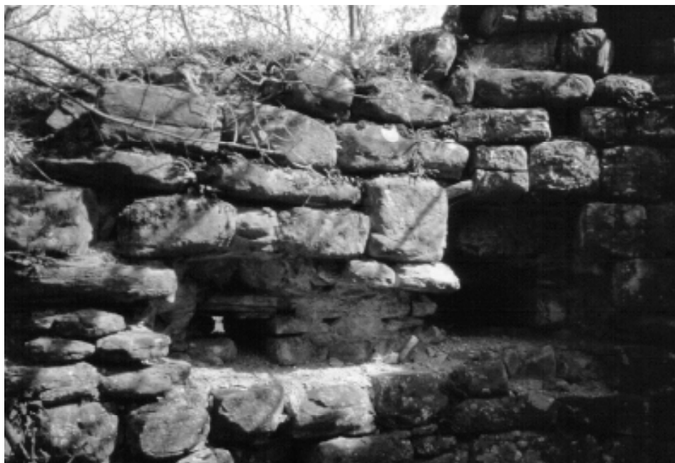
Castello di Civitella: particolare dell'interno delle mura in angolo verso Poggio Castello di Baragazza
