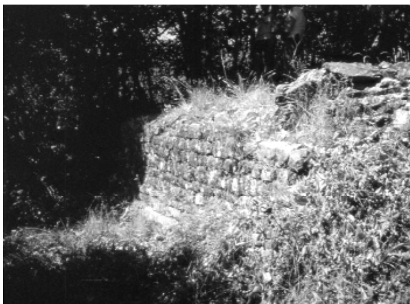
Torre di Cavarzano: ruderi del muro della Torre
