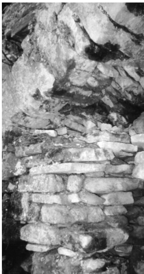
Castello delle Mogne: particolare della struttura dell'arco lato Nord
