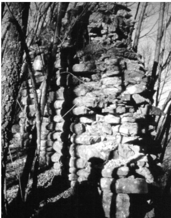
Castello di Civitella: particolare della sezione del muro verso Badia di Oppieda
