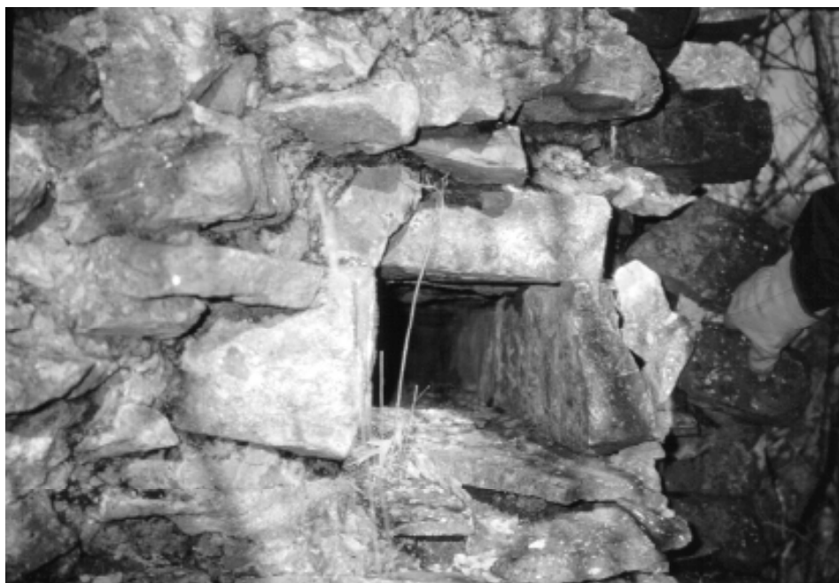
Castello di Civitella: particolare del muro esterno verso Poggio Castello di Baragazza (innesto di una palificazione)
